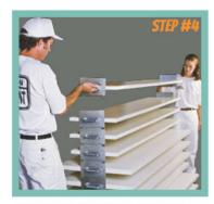
AFTER SPRAYING BOTH SIDES, STACK TO DRY, HOLLOW-CORE DOORS CAN BE STACKED UP TO 8-10 DOORS HIGH AND SOLID-CORE DOORS SHOULD ONLY STACKED 3-4 DOORS HIGH.
